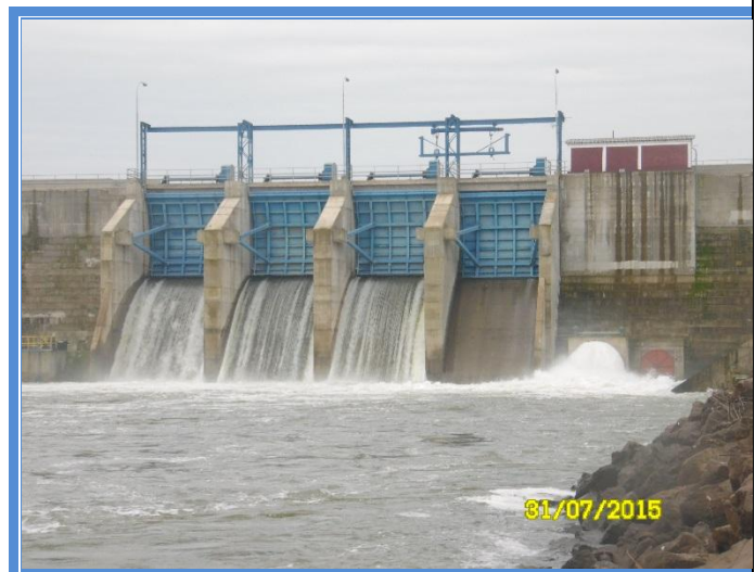
Muro Auxiliar y vertedero, aguas abajo
