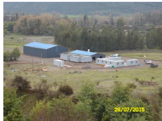
Avance Instalación de faenas Oficinas y Casino
