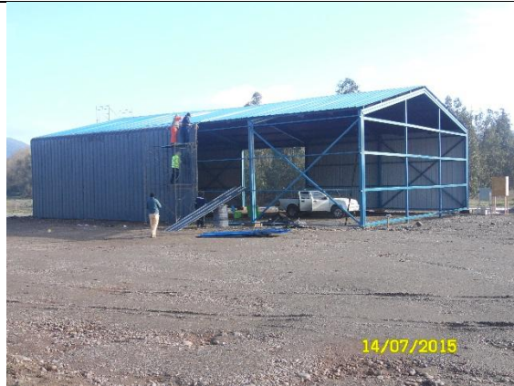
Instalación de faenas
