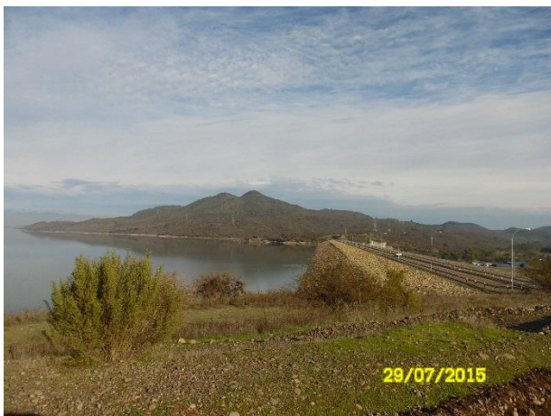
Muro Principal de Norte a Sur
