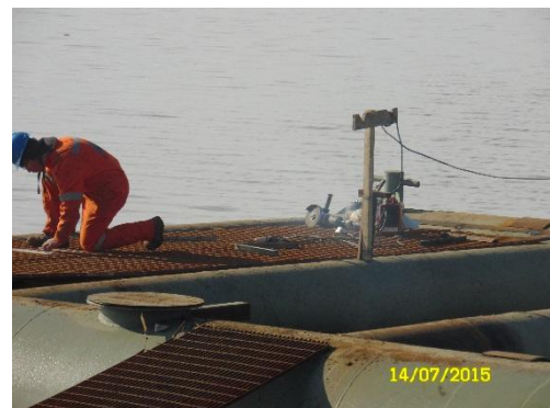
Construcción Balsa para Trabajos en Obra de Toma Túnel Sur
