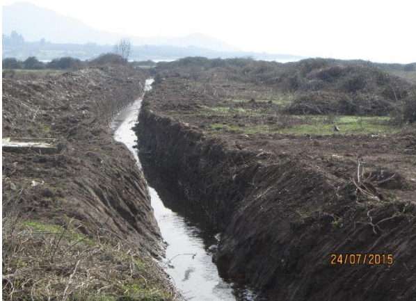
Desagüe Guzmán 3, posterior a la limpieza y retiro de biomasa
